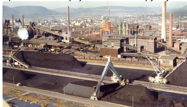
Слика 4. Депонија на јаглен и електростатски филтер како составни делови на термоенергетска постројка каде се согорува јагленов прав
